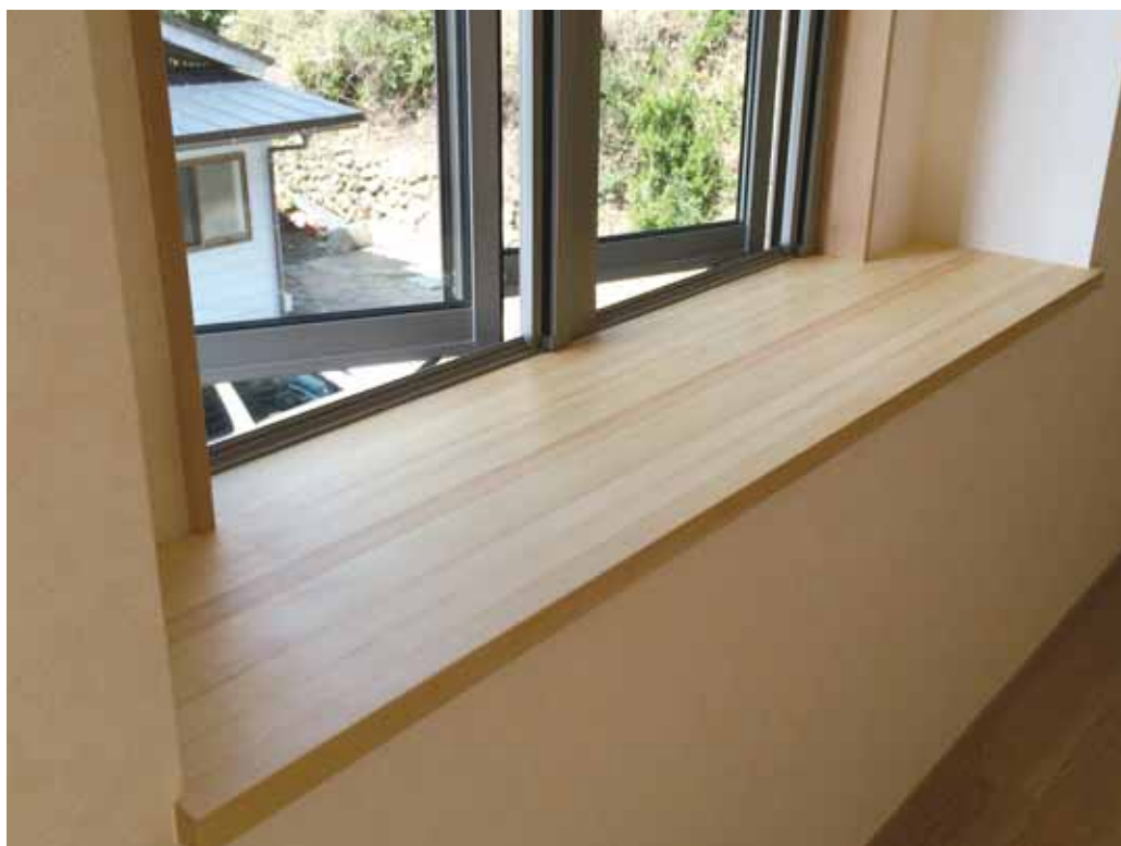
出窓カウンター
